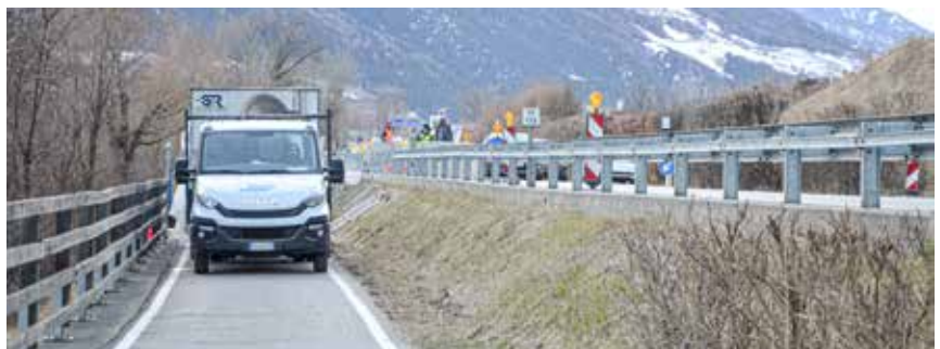
Die Arbeiten laufen bereits auf Hochtouren.
