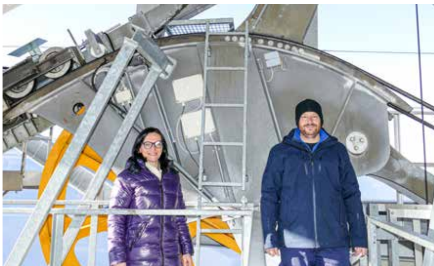
Thomas Reinstadler, einer der Mitarbeiter der Seilbahn, hatte die Gemeindereferentin Irmgard Gamper über die Wartungsstiegen bis zu einem der Laufwerke an der nunmehr überdachten Bergstation der Seilbahn geführt.
