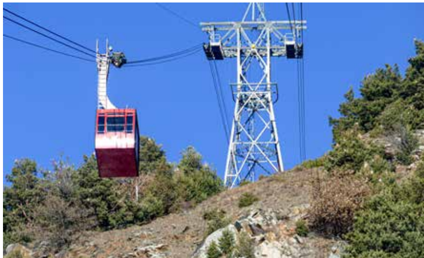
Bei der Revision wird die gesamte Seilbahnanlage auf Herz und Nieren überprüft und untersucht, und zwar bis hin zu jeder einzelnen Schraube an den Stützen.
