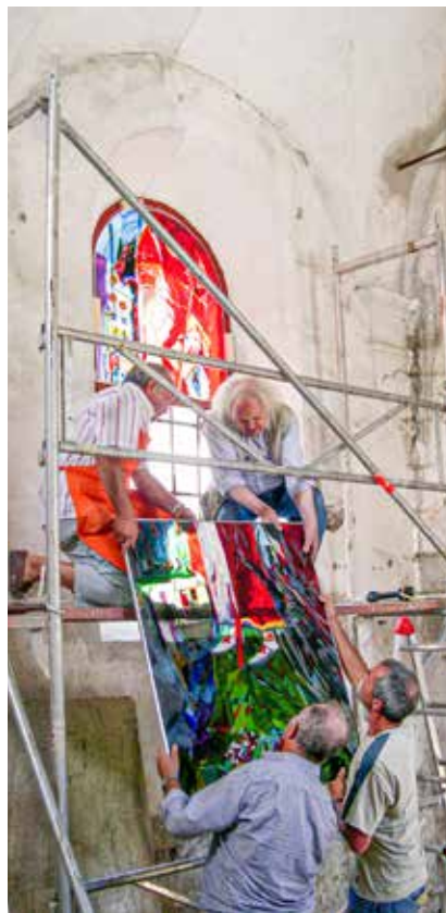
Bei der Installation des Fensters.
