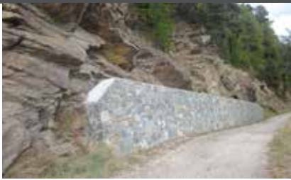
Stützmauer zur Felsensicherung
