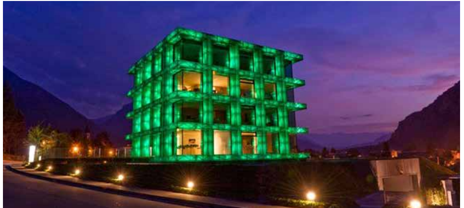
Die spektakuläre Zentrale der Rizzi-Group in Latsch – ein Glaskubus, der in 6.000 verschiedenen Farben leuchten kann.
